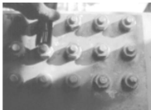
Figura 1.17 - Limpeza de porcas e parafusos
