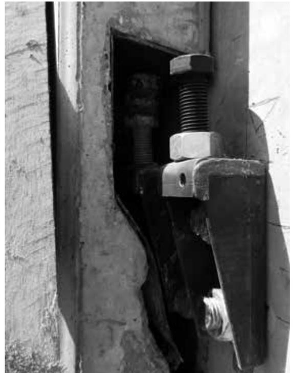
Figura 4.20 – Dispositivo com parafuso de regulagem de nível. (Acervo INOVATEC CONSULTORES)
