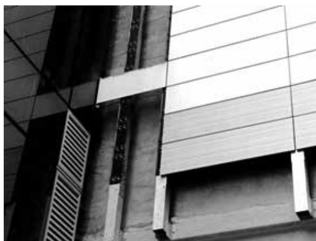
Figura 6.10 – Revestimento ventilado com painéis extrudados e sua subestrutura de alumínio. (Acervo INOVATEC CONSULTORES)
