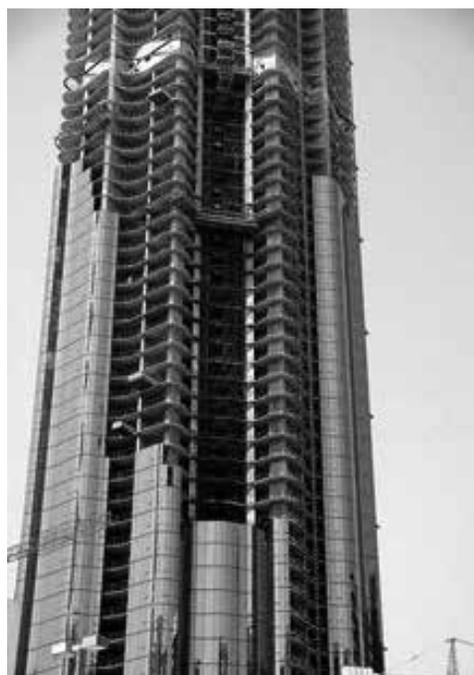
Figura 5.12 – Edifício The Shard cuja estrutura mista em aço e concreto foi envelopada com painéis de um sistema unitizado para fachadas. (FINESTRA, 2013)
