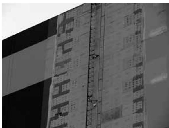
Figura 2.3 – Aplicação da camada de proteção chamada de “base coat” e acabamento final na vedação externa utilizando um sistema construtivo em LSF e placas cimentícias. (Acervo Inovatec Consultores)
