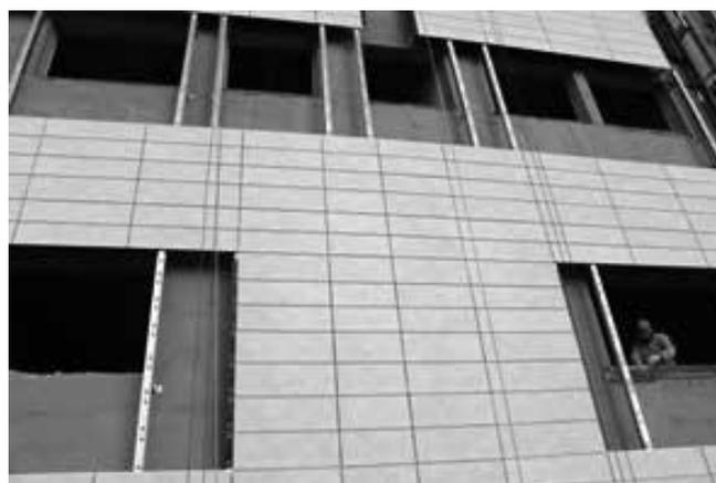
Figura 6.9 – Sistema de fachada ventilada com painéis cerâmicos extrudados em processo de instalação. (Acervo INOVATEC CONSULTORES)
