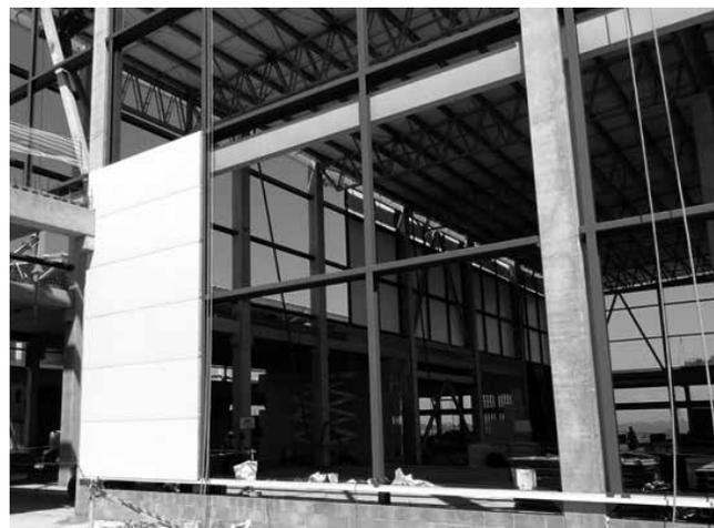
Figura 3.11 – Estrutura e subestrutura em aço de um shopping center recebendo vedações externas em painéis metálicos isolantes. O sistema tem sido utilizado largamente no Brasil em obras como esta principalmente devido à facilidade de instalação e por ser uma solução construtiva acessível.
