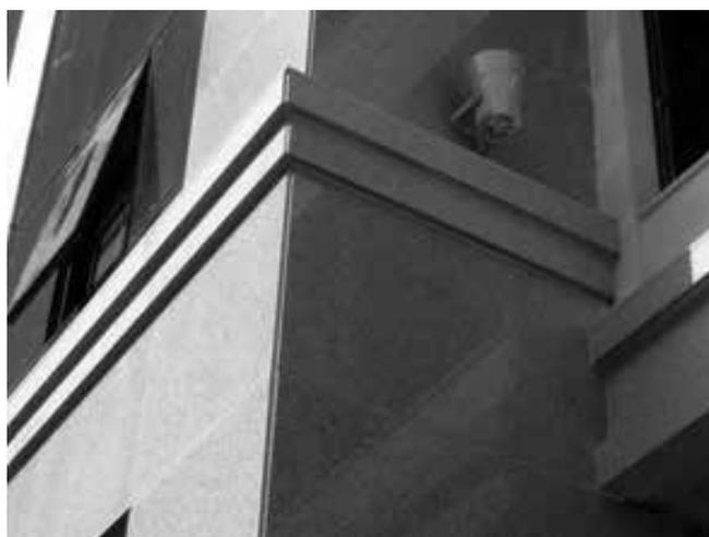
Figura 6.8 – Revestimento em granito instalado com insertos metálicos em fachada de edifício comercial. (Acervo INOVATEC CONSULTORES)
