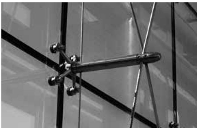
Figura 5.17 – Estrutura e fixação utilizada no sistema de fachada tipo *Spider Glass*. (PATTERSON, 2011)
