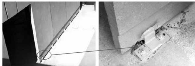
Figura 4.15 – Dispositivos de fixação dos painéis da cobertura pintados com tinta de fundo anticorrosiva. (OLIVEIRA; SABBATINI, 2004)
