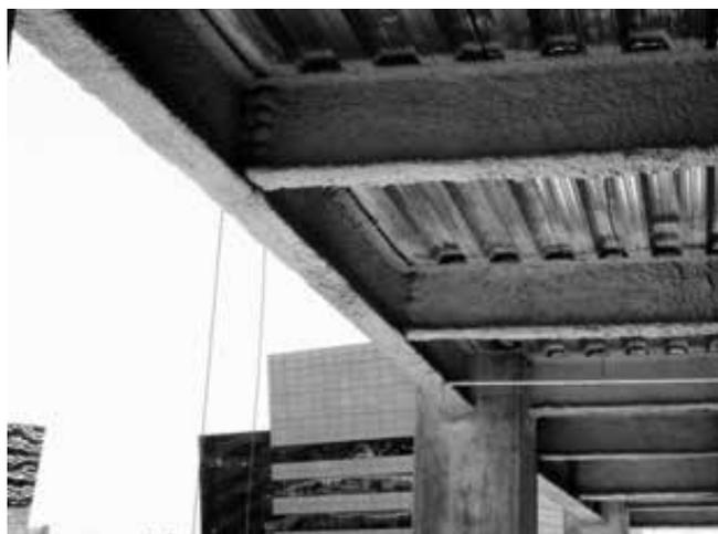
Figura 4.11 – Argamassa de vermiculita projetada sobre os perfis da estrutura metálica. (Acervo INOVATEC CONSULTORES)
