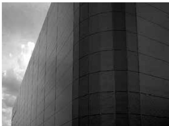
Figura 3.2 – Sistemas de vedação externa em painéis metálicos isolantes – Acabamento curvo feito por segmentos de painéis planos (DÂNICA, 2013b)
