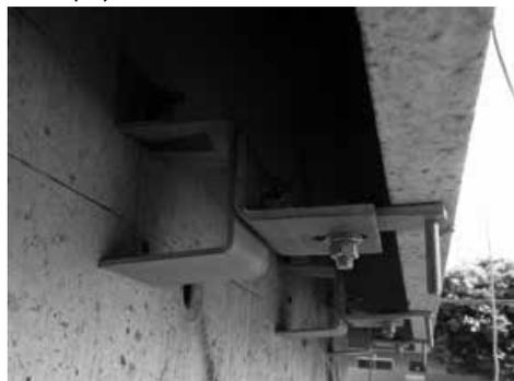
Figura 6.22 – Sistema de fixação de placas de granito. (Acervo INOVATEC CONSULTORES)
