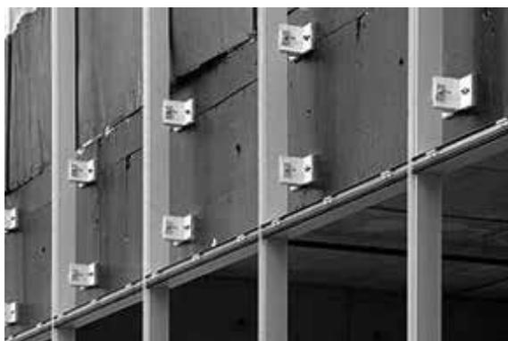
Figura 5.5 – Ancoragens, colunas e travessas instaladas. (FINESTRA, 2013a)
