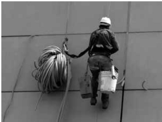
Figura 4.14 – Tratamento das juntas entre painéis com selante. Observar o uso de limitadores de fundo para definir adequadamente a seção do material. (Acervo: Inovatec Consultores)
