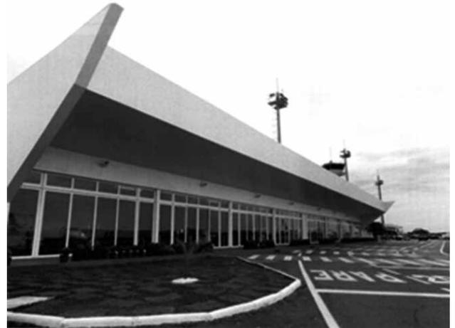
Figura 3.6 – Módulo operacional provisório instalado no aeroporto de Goiânia com fechamento em painéis metálicos isolantes. (FARIA & MARTINS, 2013).
