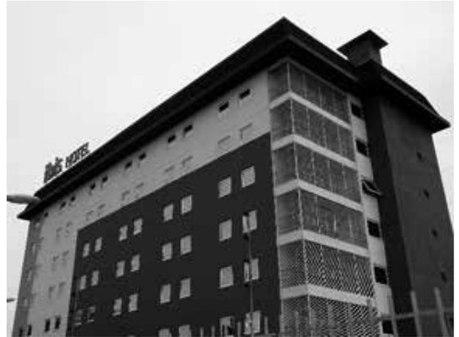
Figura 2.1 – Edifício para hotelaria com estrutura metálica e fachada em LSF e placas cimentícias. (Acervo Inovatec Consultores)
