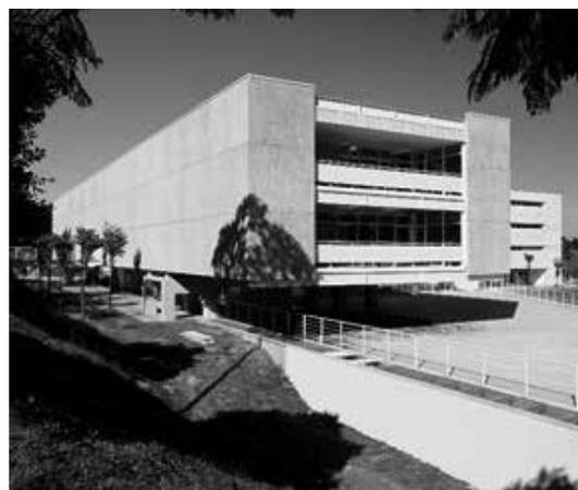
Figura 4.8 – Edifício da biblioteca central da PUC, em Campinas. Uso de painéis pré-fabricados para fechamento de edificação em estrutura metálica de aço. (foto Bebeve Viegas. Projeto Arquitetura Piratininga Arquitetos Associados PAA)
