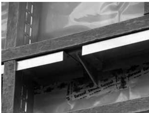
Figura 2.7 – Detalhe da fachada da Figura 2.6 mostrando uma longarina de apoio para os perfis verticais do LSF tipo cortina. (Acervo Inovatec Consultores)
