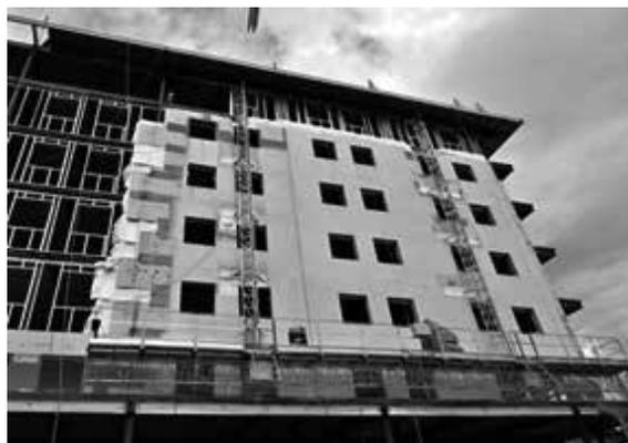
Figura 2.5 – Fachada de edifício com estrutura metálica e vedação externa em LSF e placas cimentícias. Notar que as placas de fechamento externo ficam à frente da estrutura do edifício formando um paramento contínuo (tipo semicortina). (Acervo Inovatec Consultores).
