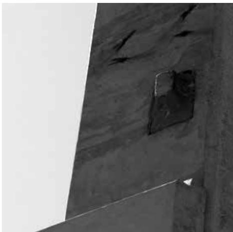
Figura 4.19 – Dispositivo de fixação metálico com encaixe tipo macho-fêmea. (Acervo INOVATEC CONSULTORES)
