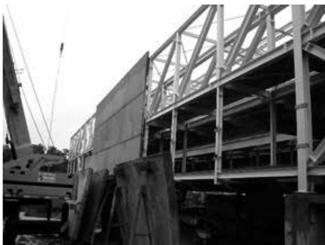
Figura 4.9 – Aspecto da montagem dos painéis da fachada da biblioteca central da PUC. Os painéis são suspensos, apoiados nas vigas metálicas e então fixados com cantoneiras de aço. (Acervo PAA)
