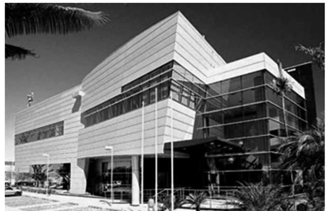
Figura 3.8 – Fachada de edifício comercial composta por painéis metálicos isolantes e vidros. (FINESTRA, 2004)
