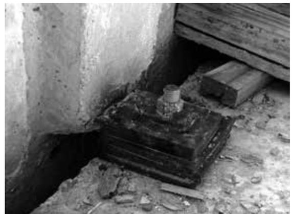
Figura 4.21 – Irregularidade na tentativa de se ajustar o nível do painel. Também é possível notar a corrosão dos elementos de fixação que não receberam tratamento superficial de proteção. (OLIVEIRA, 2002)
