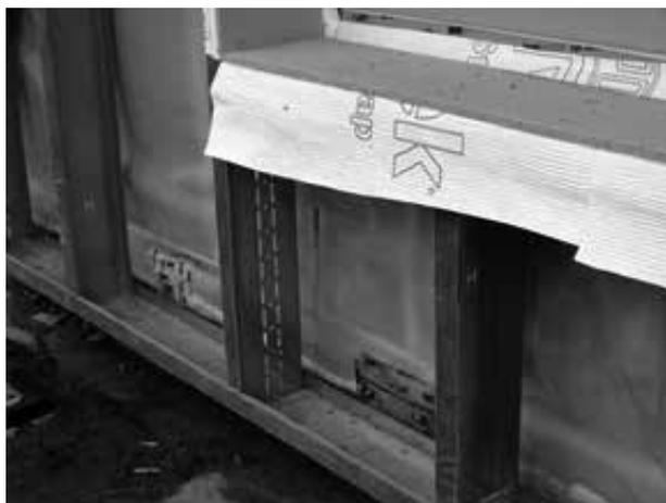
Figura 2.6 – Detalhe da vedação em LSF do tipo cortina onde todo o sistema fica externo à estrutura principal do edifício. Acervo Inovatec Consultores)
