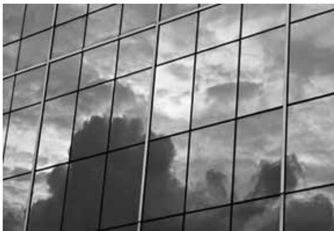
Figura 5.28 – Aspecto da fachada quando utilizados vidros refletivos. (DNA VIDROS, 2013)
