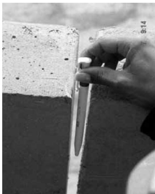
Figura 4.7 – O afastamento entre painéis pré-fabricados precisa ser uniforme para facilitar a vedação e conferir estética adequada. (OLIVEIRA; SABBATINI, 2004)
