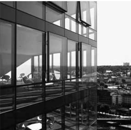
Figura 5.32 – Sistema de fachada unitizado que permite a abertura de janelas. (SCHÜCO, 2013)
