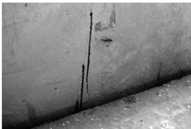
Figura 4.12 – Painel pré-fabricado de concreto que apresentou fissura no sentido transversal a sua maior dimensão. Foi utilizada injeção de polímero na recuperação. (Acervo: Inovatec Consultores)
