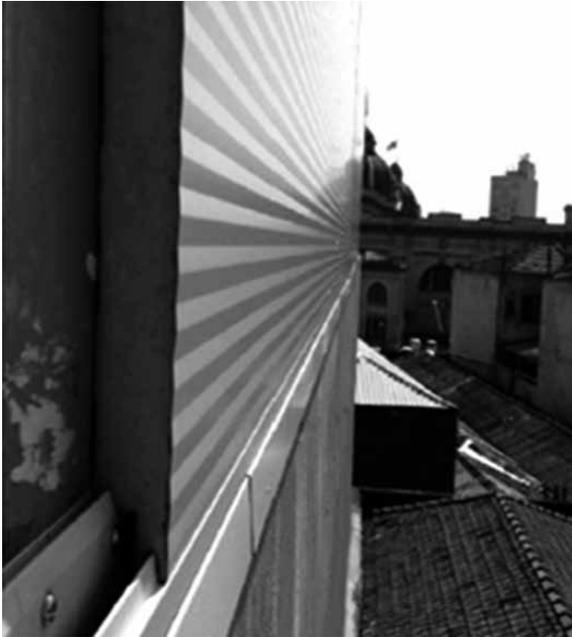
Figura 3.16 – Detalhe de encaixe entre apoio suspenso e painel metálico isolante. (DÂNICA, 2013b)
