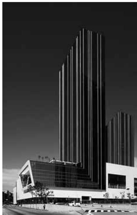
Figura 5.4 – Complexo WTJK, em São Paulo. Uso do sistema *structural glazing* para fachada das torres. (GELINSKI, 2013b)
