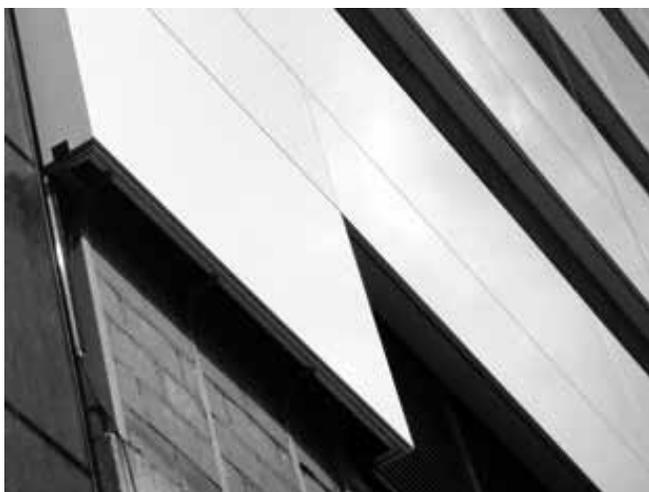
Figura 6.3 – Painéis de ACM instalados em fachada de edifício comercial com vedação convencional de alvenaria. (Acervo INOVATEC CONSULTORES)
