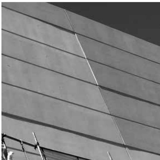
Figura 4.10 – Desalinhamento das juntas entre painéis pré-fabricados em uma obra de um centro comercial. (Acervo: Inovatec Consultores)
