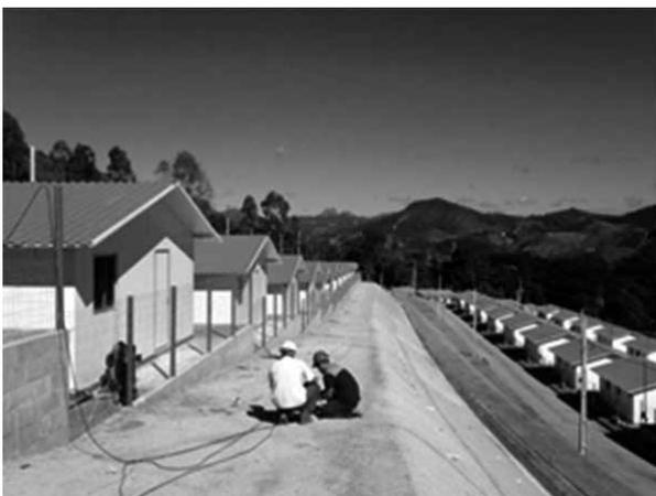
Figura 3.5 – Casas modulares construídas com painéis metálicos isolantes. (FISCHER, 2013).
