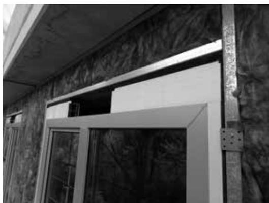
Figura 2.4 – Detalhe da vedação com LSF do tipo embutida (entre lajes) ainda sem os painéis de fechamento, mostrando o uso da lâ mineral. (Acervo Inovatec Consultores)
