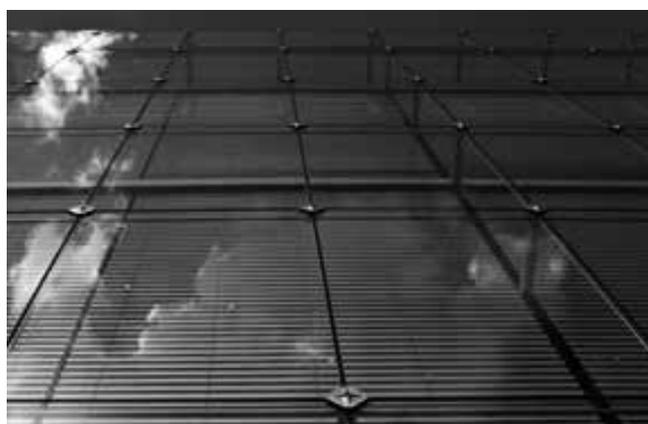
Figura 5.19 – Edifício da Loyola University, em Chicago. Fachada com sistema de fixação para vidros tipo *point-fixed-clamped*. (PATTERSON, 2011)
